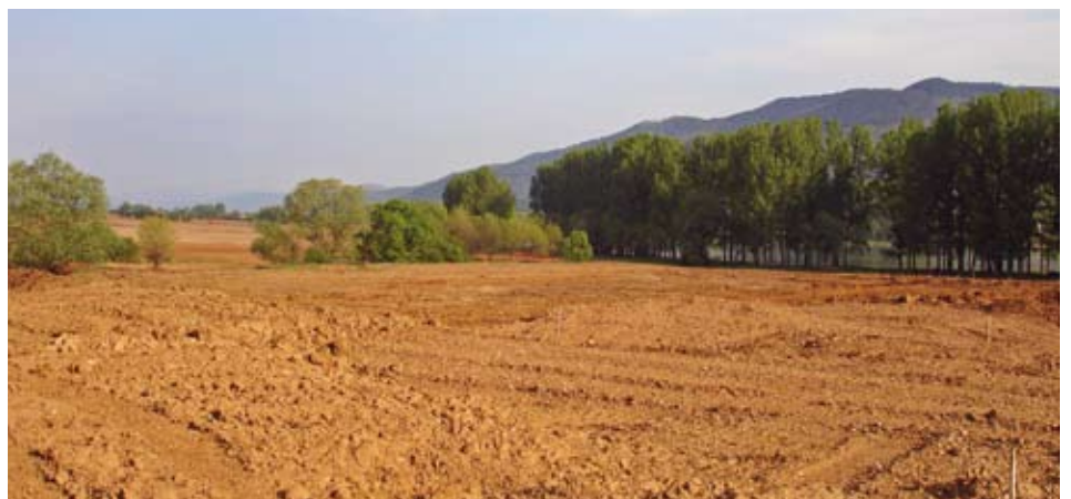
Hole 8 voor constructie
