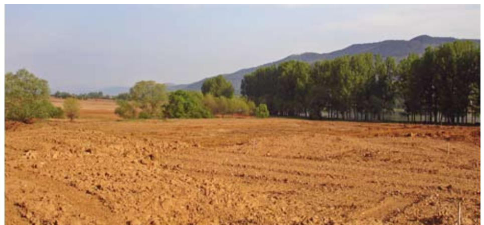
Hole 8 voor constructie
