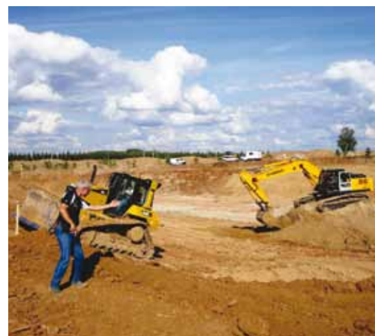
De aanleg van het irrigatiemeer, dat meer dan 100'00 m 3 water bevat.
